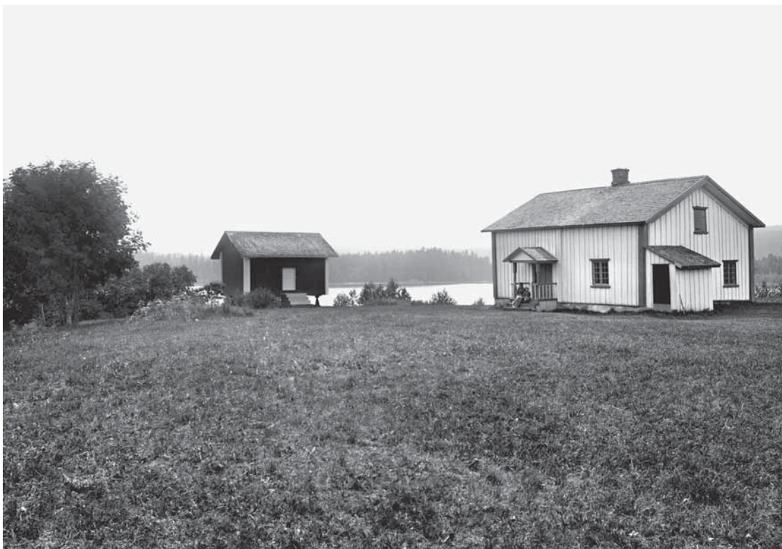
Rødstua på Nes ca. 1890. Leilendingene på Nes bodde i stua, som ble flyttet nordover da de nye husa på Nes ble bygd i 1900. (Eier Rigmor Vesje, Oslo).
