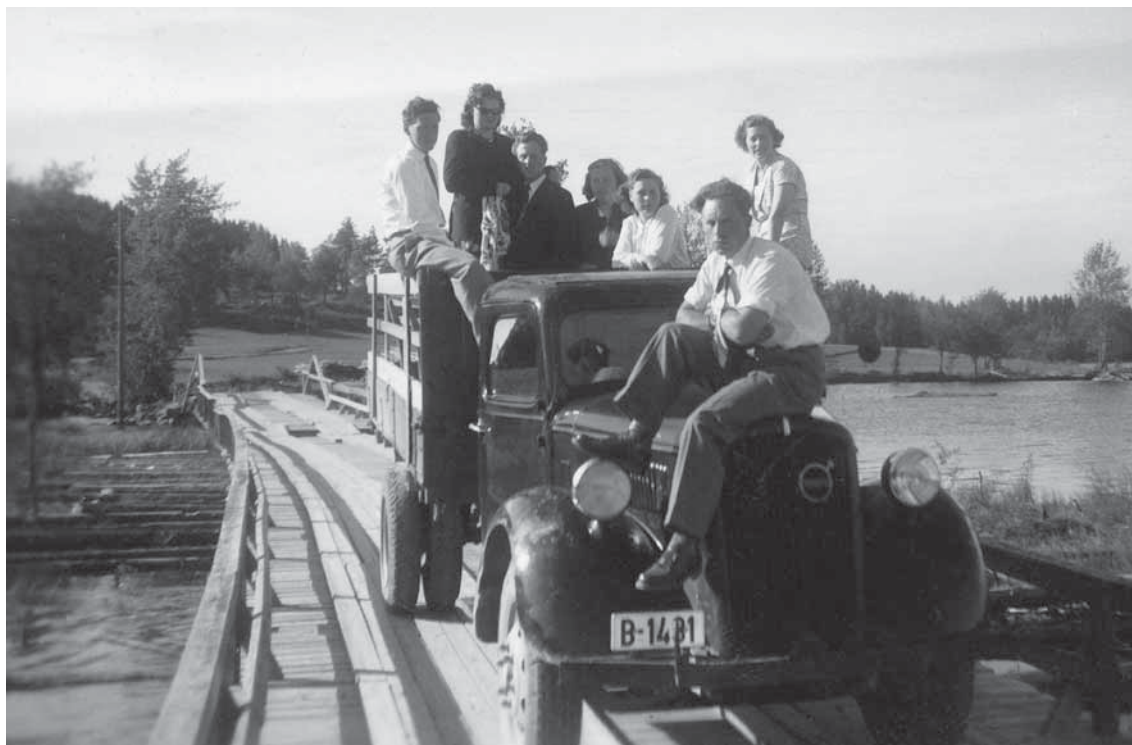
Det gikk vei over Hagasundet og videre forbi Nes. Det ble ferjet her til 1899, da det ble bygd flytebru over sundet. Rittmester Ove Gedde i Setskog lærte å bygge flytebrygger av torv på Cuba i 1895. Ferjemannen bodde på plassen Sundet ytterst på Nordneset. På bildet. Bak fra venstre: Kolbjørn Bergquist, Rebekka Haga, Bjarne Brekke, Edel Haga, Astrid Holmedal og Marry Holmedal. På panseret Asbjørn Holmedal.
