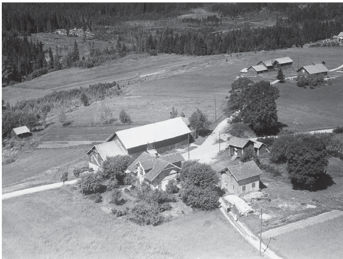
Nord-Trandem med Ødegården i bakgrunnen. Låven ble revet på 1960-tallet. Kjona til venstre i bildet. (Widerøe 1953).
