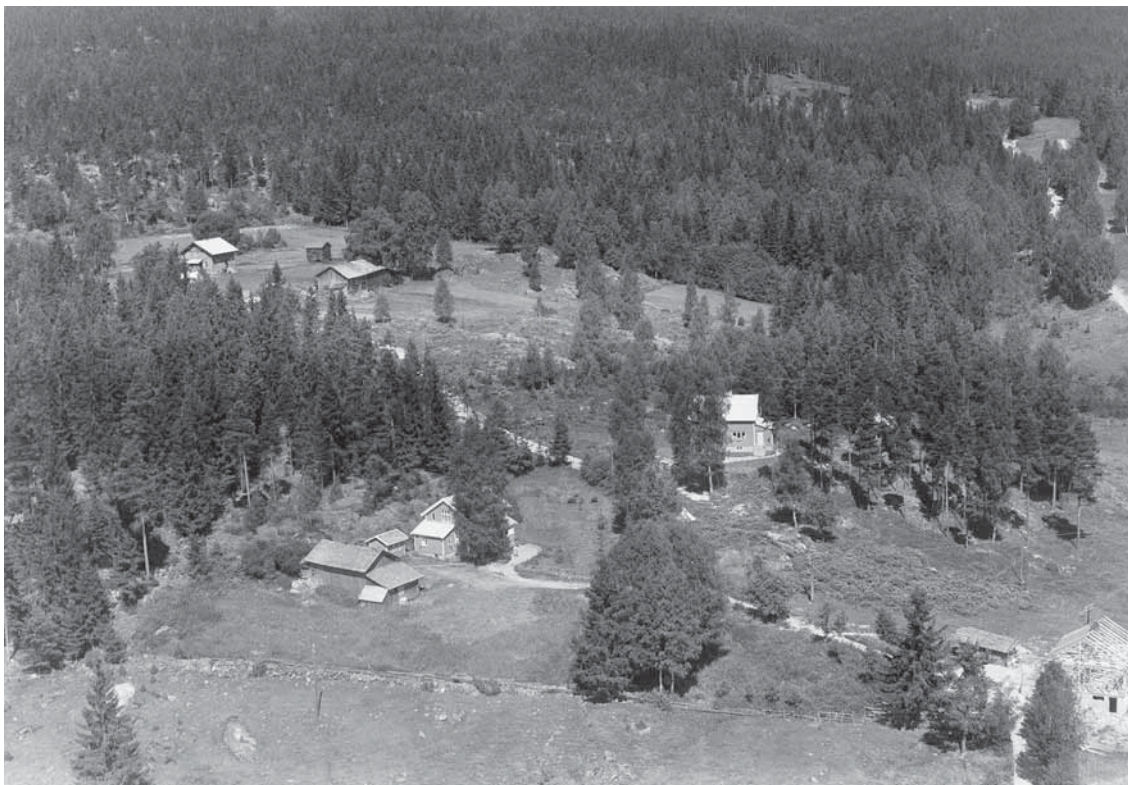
Skogheim nærmest til venstre i bildet. Haga ligger bak og boligen Skogstad midt i bildet. Boligen Solheim er under bygging. (Widerøe 1953).
