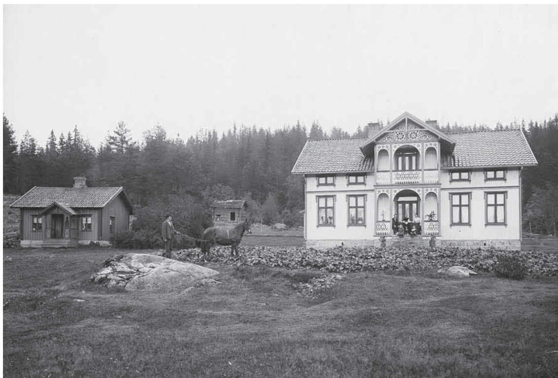
Trandemsætra ca. 1910. Våningshuset er fra ca. 1900. Bryggerhuset til venstre i bildet ble flyttet i 1927 til plassen der det står i dag. Det ble bygd tidlig på 1800-tallet, og etter restaurering brukes det nå som gjestehus. Huset i bakgrunnen er smie og verksted. Jørgen Jovall holder hesten, og på trappa sitter barna Helga og Bertha (Helga til venstre). Bak sitter fra venstre: Theodor Olsen, Helene Jovall og Marie Jovall. (Foto: Eier Jørgen Dahl).
