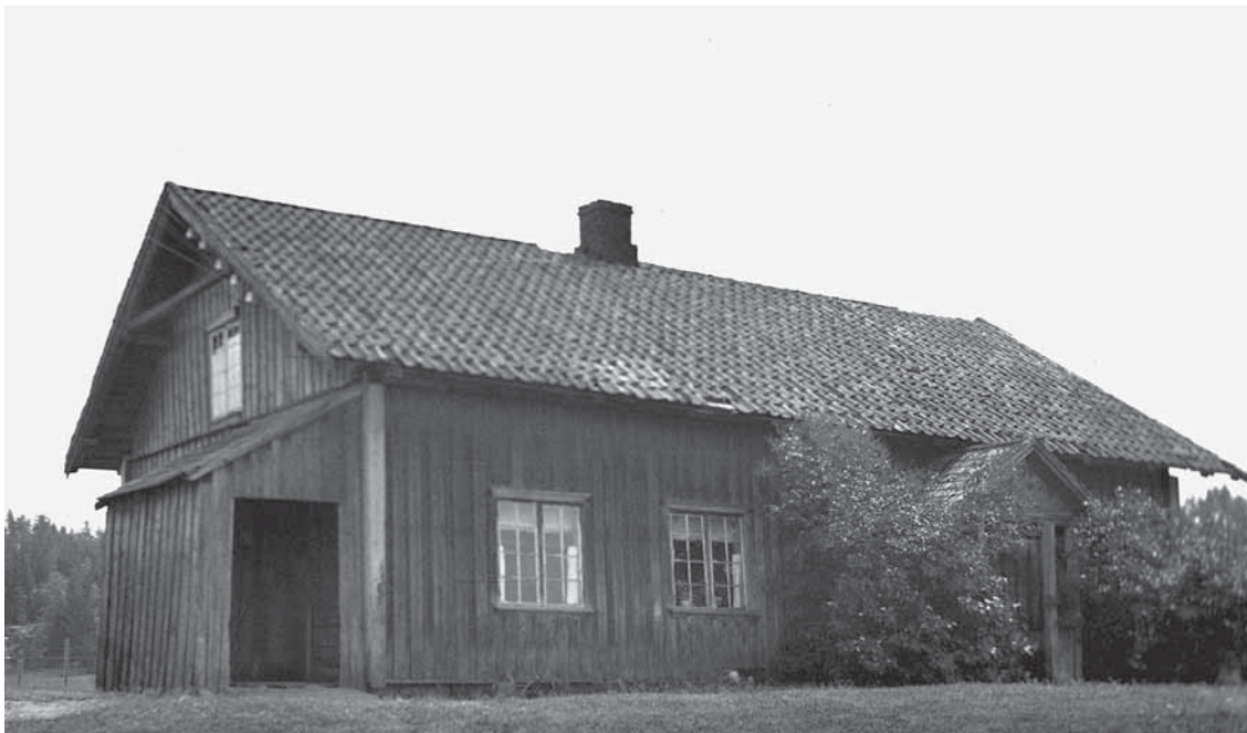
Stua på Ødegården ble bygd i 1843. Bildet er tatt i 1937. (Foto: Ingebret Aas, Sarpsborg).
