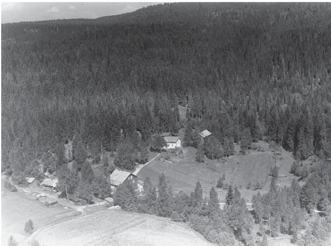
Kopperud mølle, den store bygningen nærmest i bildet. Kopperudsaga lå lenger opp i elva. (Widerøe 1953).
